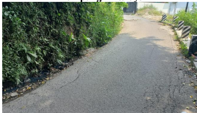
Gambar 4.3 Kondisi Jalan Lingkungan dan Saluran Drainase di Kampung Tirtalaya
